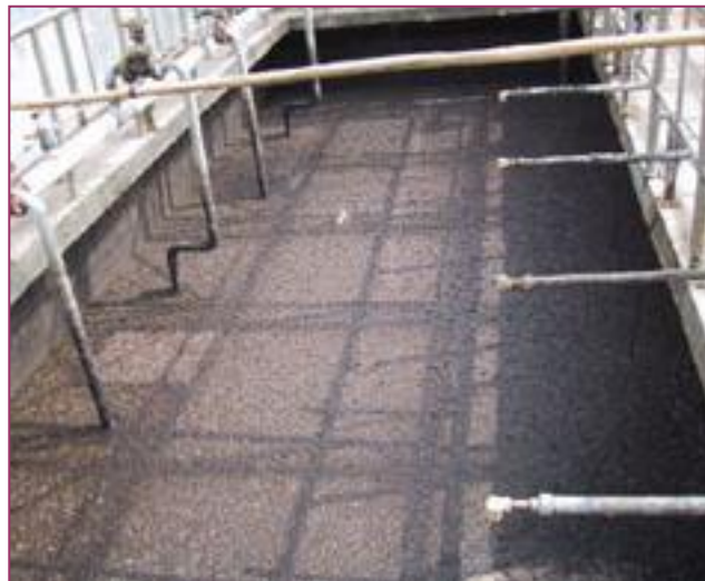
Primario Bacino di Sedimentazione
